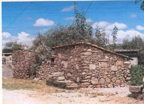
El sistema constructivo predominante son los muros de piedra asentados con arcilla. En la localidad de México Lindo se encuentra un sistema constructivo mixto donde la cimentación de piedra se prolonga hasta 1 metro y a partir de él se desplanta el muro de adobe, en algunas ocasiones el muro va recubierto con arcilla.
